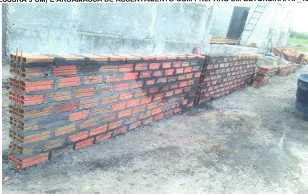
Foto 06- ALVENARIA DE VEDAÇÃO DE BLOCOS CERÂMICOS FURADOS NA HORIZONTAL DE 9X19X29 CM (ESPESSURA 9 CM) E ARGAMASSA DE ASSENTAMENTO COM PREPARO EM BETONEIRA. AF_12/2021
