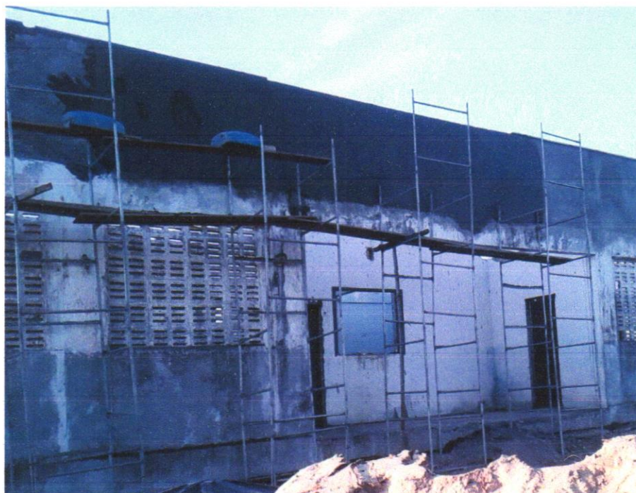
Foto 16 - MASSA ÚNICA, PARA RECEBIMENTO DE PINTURA OU CERÂMICA, ARGAMASSA INDUSTRIALIZADA, PREPARO MECÂNICO, APLICADO COM EQUIPAMENTO DE MISTURA E PROJEÇÃO DE 1,5 M 3 /H EM FACES INTERNAS DE PAREDES, ESPESSURA DE 5MM, SEM EXECUÇÃO DE TALISCAS. AF_06/2014
