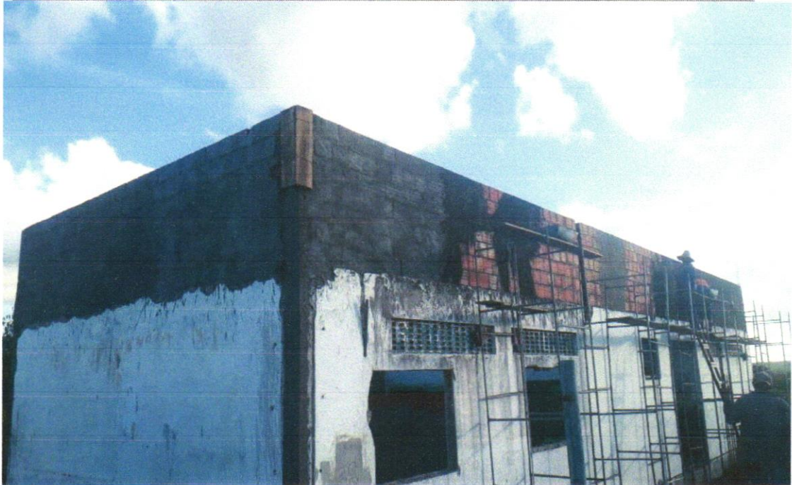
Foto 13- CHAPISCO APLICADO EM ALVENARIA (COM PRESENÇA DE VÃOS) E ESTRUTURAS DE CONCRETO DE FACHADA, COM EQUIPAMENTO DE PROJEÇÃO. ARGAMASSA TRAÇO 1:3 COM PREPARO EM BETONEIRA 400 L. AF_06/2014
