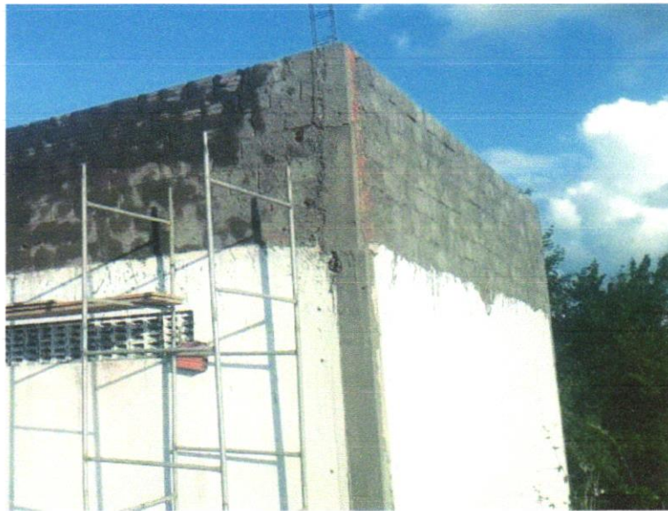
FOTO 01 – (COMPOSIÇÃO REPRESENTATIVA) EXECUÇÃO DE ESTRUTURAS DE CONCRETO ARMADO, PARA EDIFICAÇÃO HABITACIONAL UNIFAMILIAR TÉRREA (CASA EM EMPREENDIMENTOS), FCK = 25 MPA. AF_01/2017
