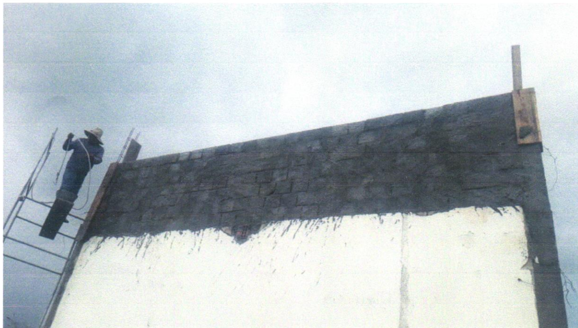
Foto 11 - CHAPISCO APLICADO EM ALVENARIA (COM PRESENÇA DE VÃOS) E ESTRUTURAS DE CONCRETO DE FACHADA, COM EQUIPAMENTO DE PROJEÇÃO. ARGAMASSA TRAÇO 1:3 COM PREPARO EM BETONEIRA 400 L. AF_06/2014
