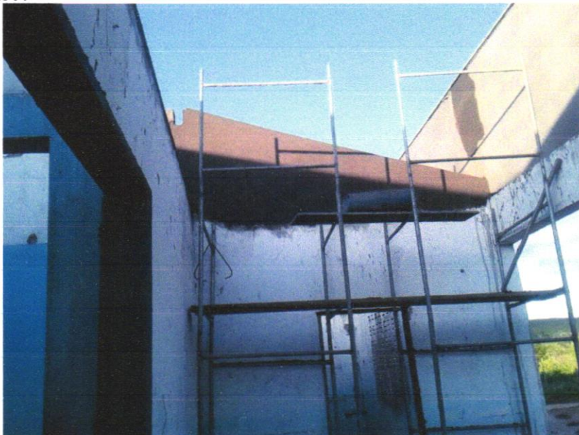
Foto 18 - MASSA ÚNICA, PARA RECEBIMENTO DE PINTURA OU CERÂMICA, ARGAMASSA INDUSTRIALIZADA, PREPARO MECÂNICO, APLICADO COM EQUIPAMENTO DE MISTURA E PROJEÇÃO DE 1,5 M 3 /H EM FACES INTERNAS DE PAREDES, ESPESSURA DE 5MM, SEM EXECUÇÃO DE TALISCAS. AF_06/2014
