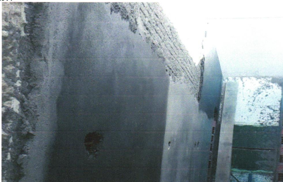
Foto 20 - MASSA ÚNICA, PARA RECEBIMENTO DE PINTURA OU CERÂMICA, ARGAMASSA INDUSTRIALIZADA, PREPARO MECÂNICO, APLICADO COM EQUIPAMENTO DE MISTURA E PROJEÇÃO DE 1,5 M3/H EM FACES INTERNAS DE PAREDES, ESPESSURA DE 5MM, SEM EXECUÇÃO DE TALISCAS. AF_06/2014
